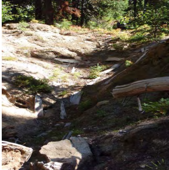
Photo 7. Collapsed Adit 3. Latitude 45.47824°N, Longitude -116.06204°W
