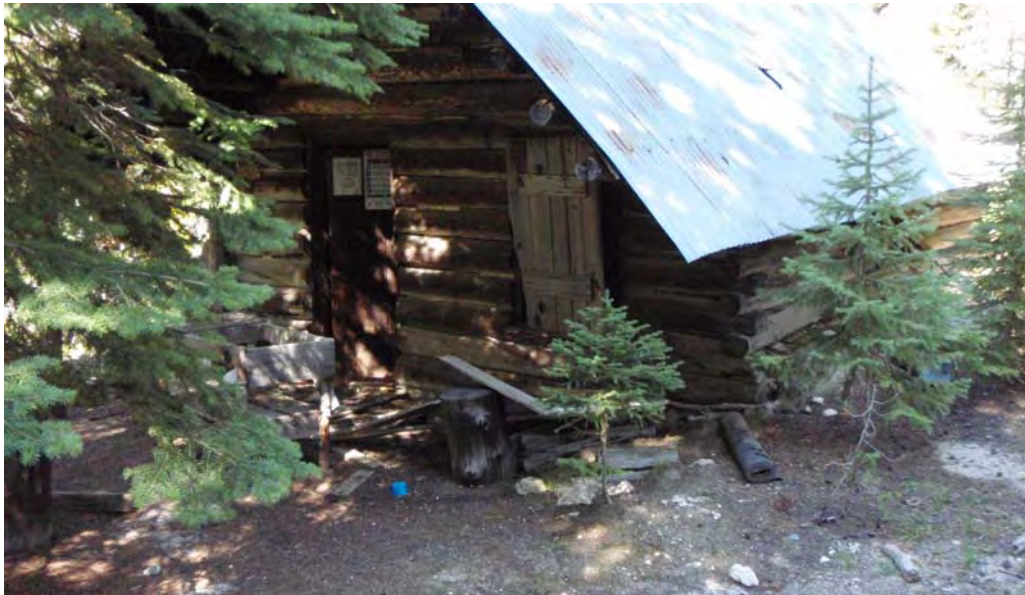
Photo 5. Cabin on north side of Shaft 1. Latitude 45.47805°N, Longitude -116.06209°W
